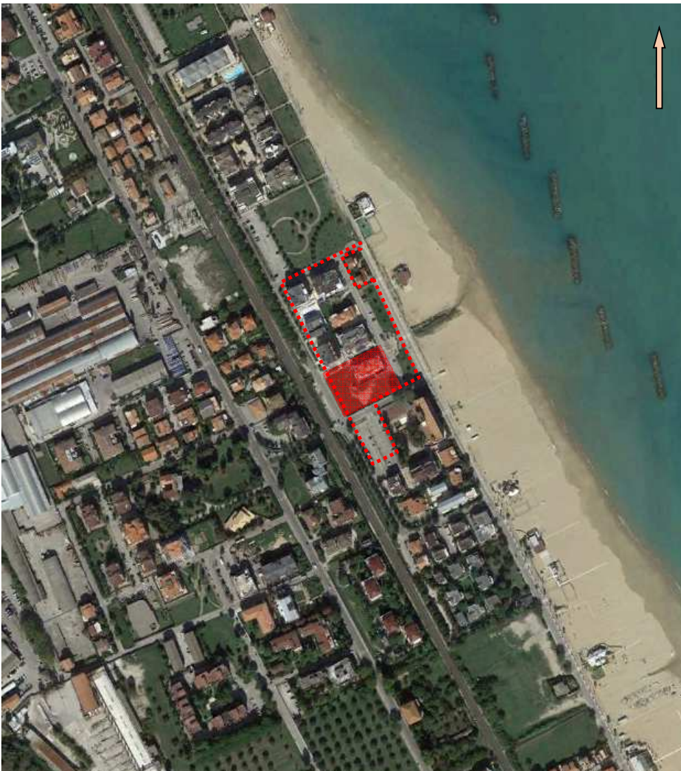
Fig.3 Immagine satellitare da Google Earth. La linea tratteggiata indica la lottizzazione "Colle Quattrini Mare". L'area evidenziata in rosso, il lotto oggetto di variante.
